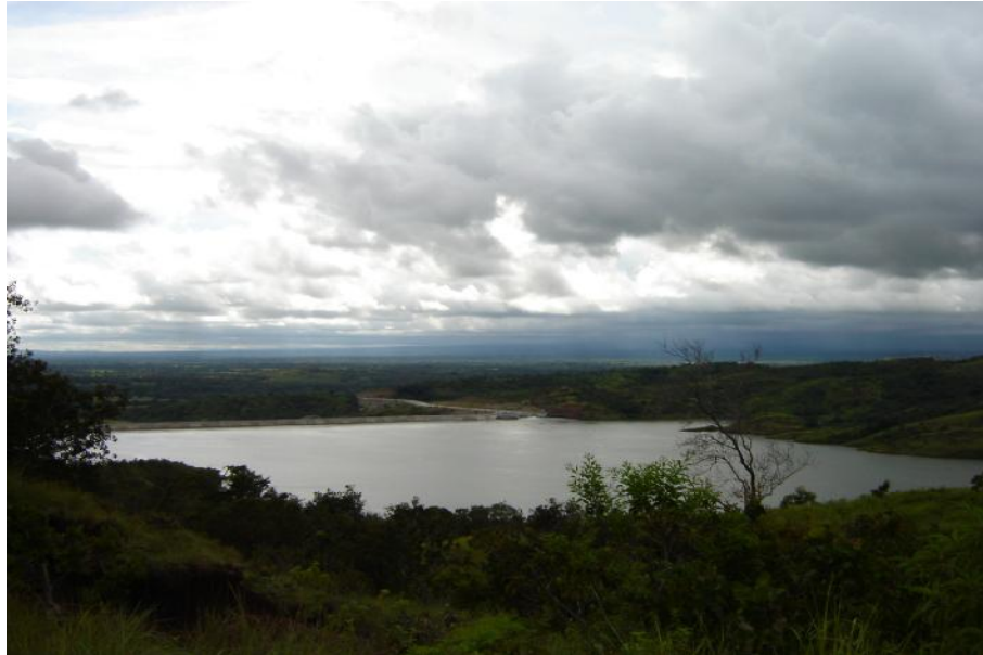
Fig. 2. Vista del Embalse Barrigón y su presa.
