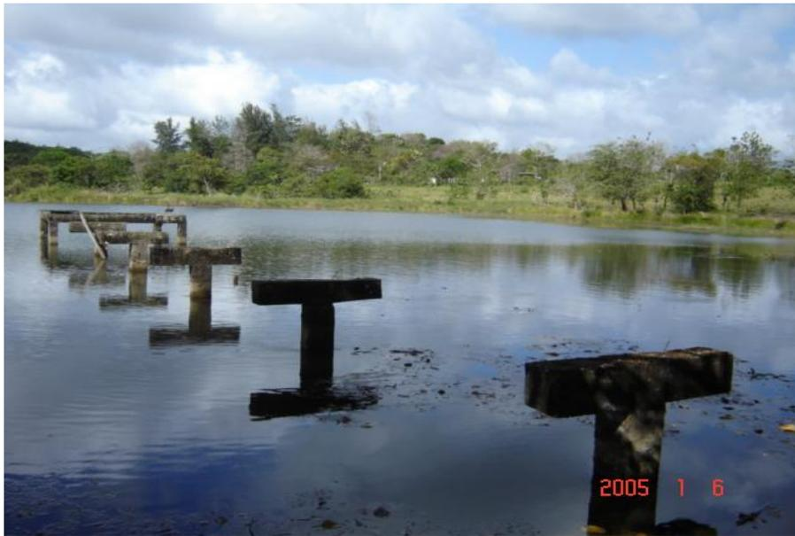
**Fig. 3** Infraestructuras anteriormente utilizadas para soporte de muelle
