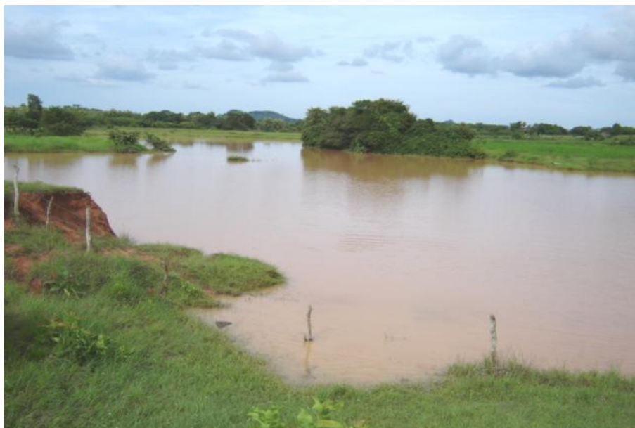
Fig. 2. Vista del reservorio La Colorada
