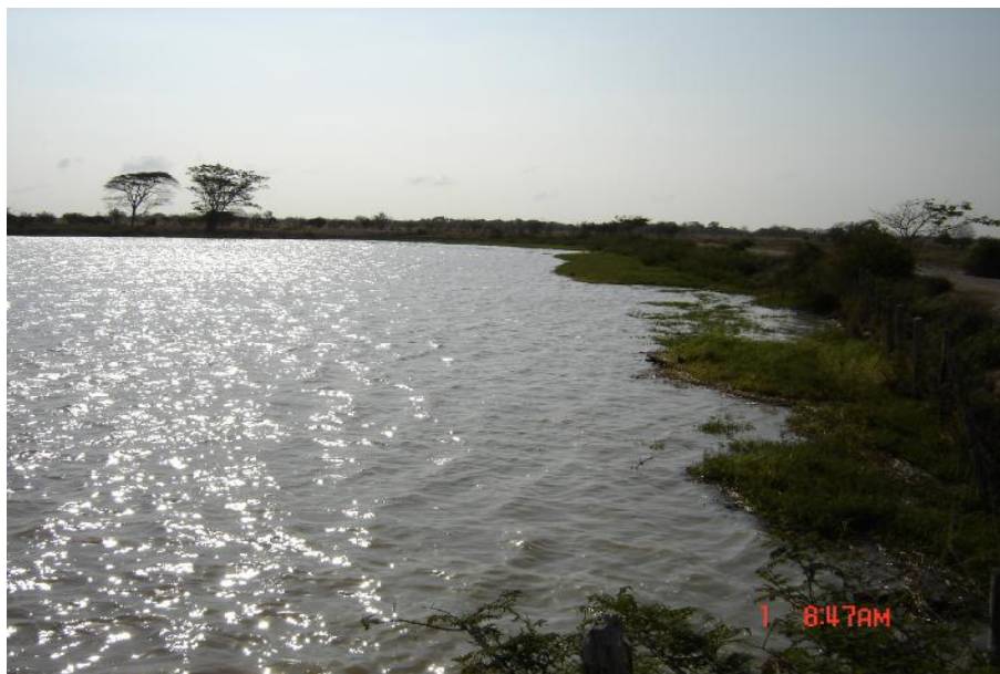
Fig. 2. Vista del reservorio, La Monita
