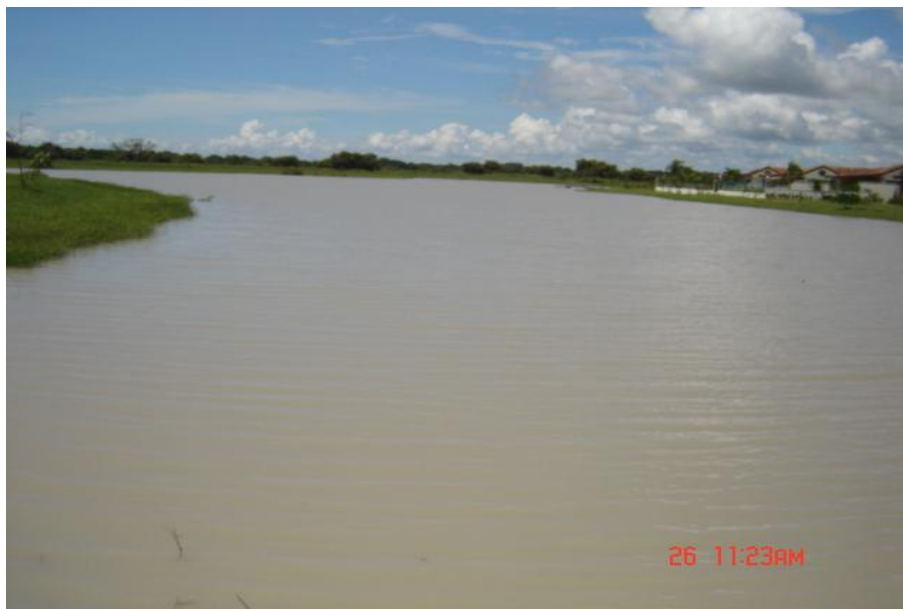
Fig. 2. Vista del reservorio, Lago 11 Buenaventura
