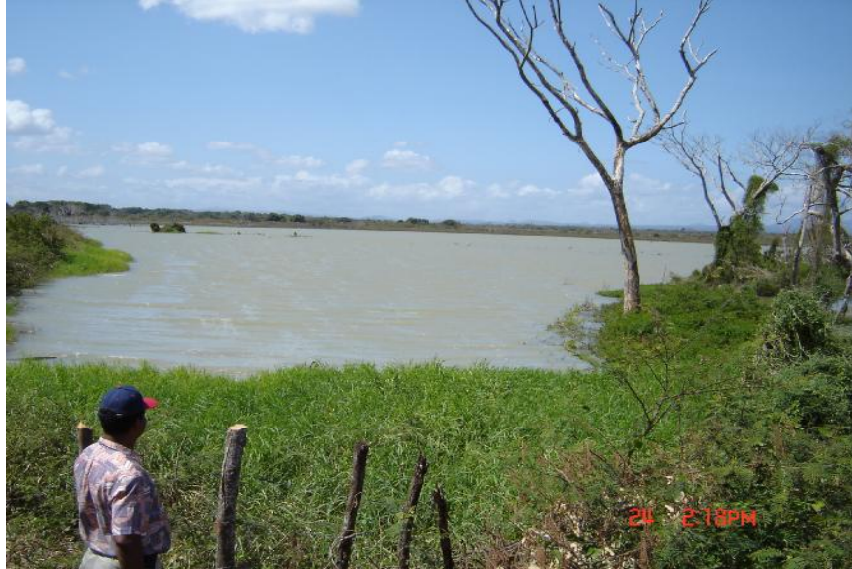
Fig. 2 Vista del Reservorio Santa Mónica
