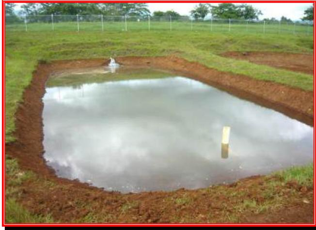
Fig. 16. Estanque construido en tierra de 300 m<sup>2</sup> tipo rústico, se observa la entrada y salida de agua.
